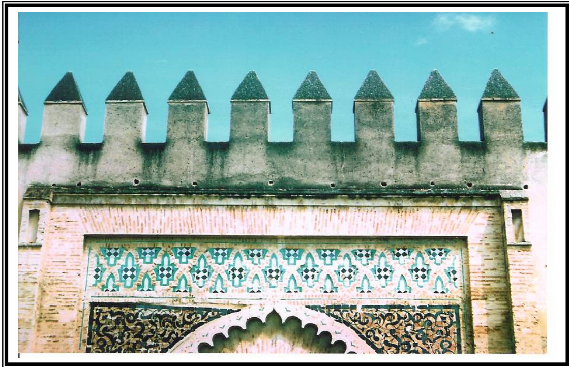
الصورة رقم (35) : " مدينة فاس الجديد " – تقنية بناء الشرفات و زخرفة المدخل (باب الأمر).
